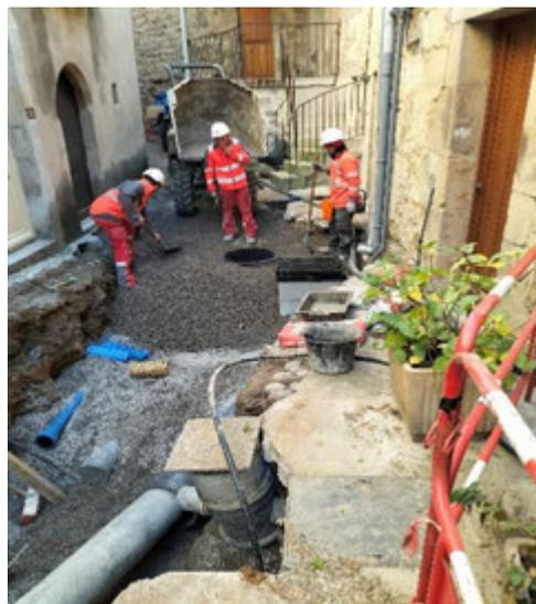
Les travaux de réhabilitation des réseaux d'eau potable, eaux usées et pluvial de la rue de Jalès se terminent. Il reste à poser la couverture de la chaussée, en pavés, conformément aux prescriptions du règlement du Site Patrimonial Remarquable.
